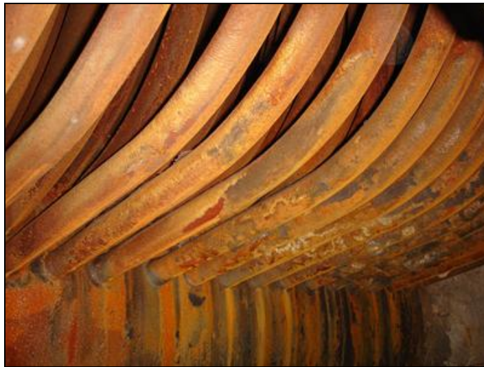
Рисунок 1.4. Фотографія кип'ятильних труб (нижній барабан)
